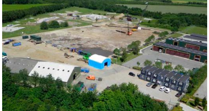
Figur 6-2 Kompressorarealet i Egtved.
